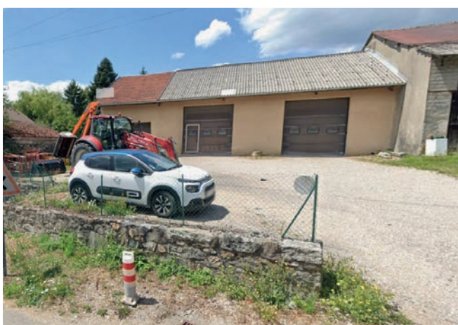
Vue sur le centre technique depuis la route de la Crapière
